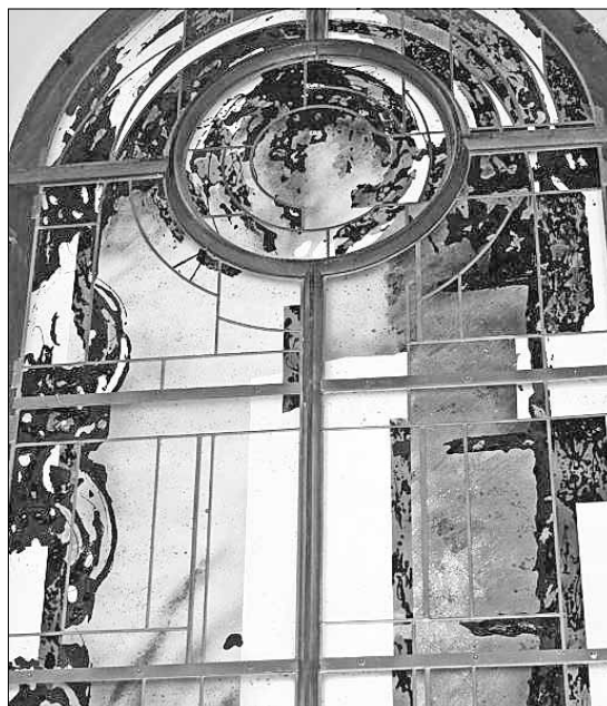
neu gestaltetes Südfenster
